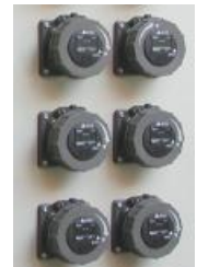
Socle de prises 16A pour raccordement rampe
