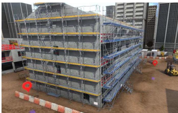
Zone des deux échafaudages
