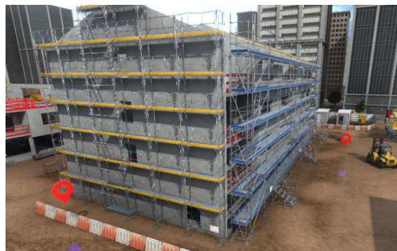
Vue 3D aérienne du lieu de chantier
