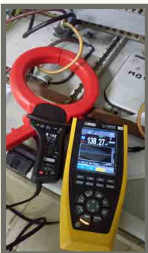
Mesure avec pince de courant de fuite et enregistrement du défaut.
