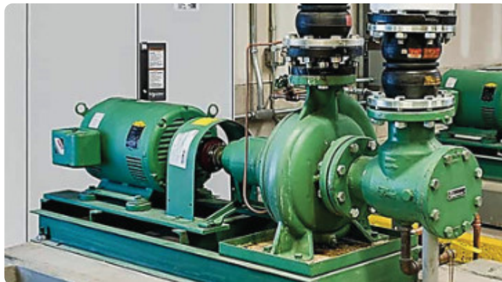
Le désalignement est critique dans les installations a machines accouplées (transmission directe)
