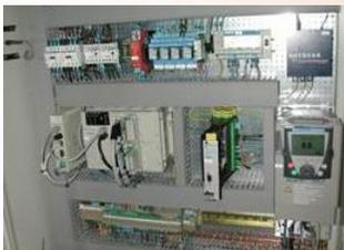
Armario de mando con servidor web embarcado y tarjeta proporcional
